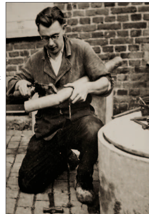
Wiel Kömhoff bij het solderen van een zinken hemelwaterafvoer. Rechts zien we nog een gedeelte van een regenwaterput.
