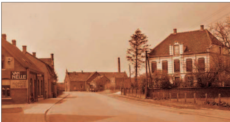
De Steenstraat in 1942. Links zien we het bedrijf van Kömhoff, toen nog met benzinepomp voor het huis. In het midden van de foto zien we de Fui en rechts de villa van de familie Engels. Foto: collectie Twan Niessen
