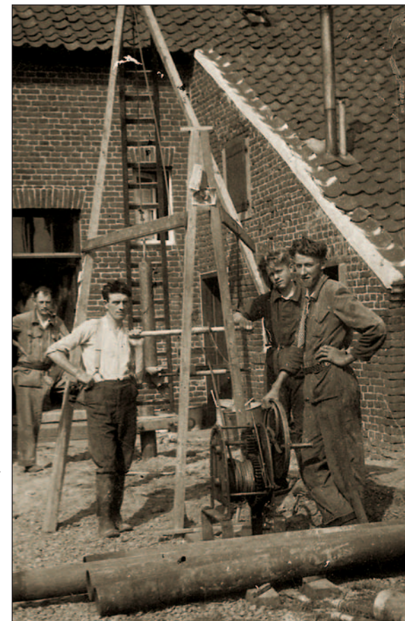
Enkele medewerkers van Kömhoff aan het werk bij het boren van putten. Het bedrijf was hierin gespecialiseerd.
